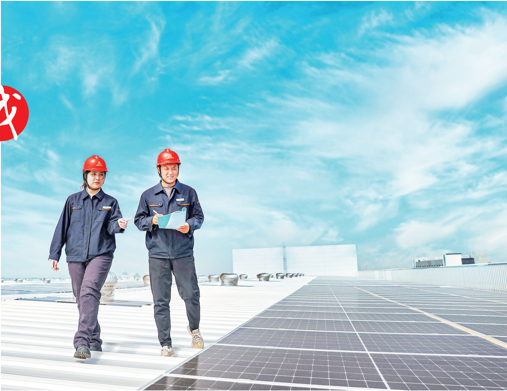
能源职工正在对50MW分布式光伏发电项目屋顶光伏组件进行日常巡检。
