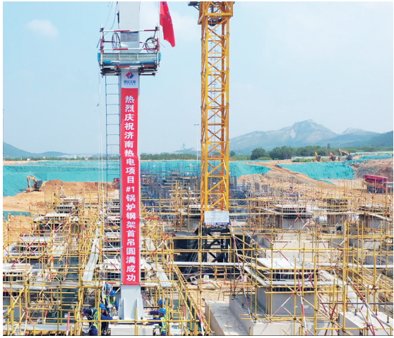
2×66万千瓦先进燃煤机组供热项目,锅炉基础及钢架施工作业紧张有序进行。
