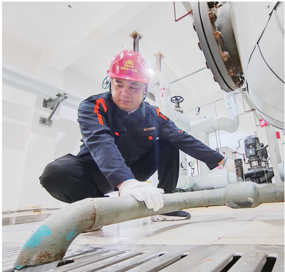
供暖管家正在换热站内进行排污作业。节日期间,开展供热注水打压和冷态调节等供热前准备工作。
