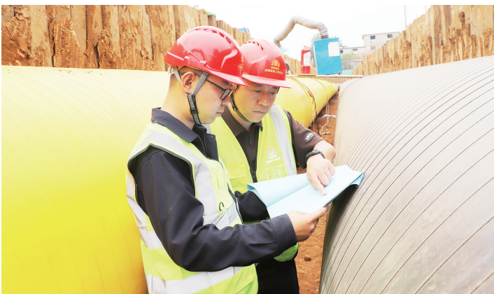
“石热入济”管网工程现场,施工员一边巡查,一边与设计图纸进行校对。
