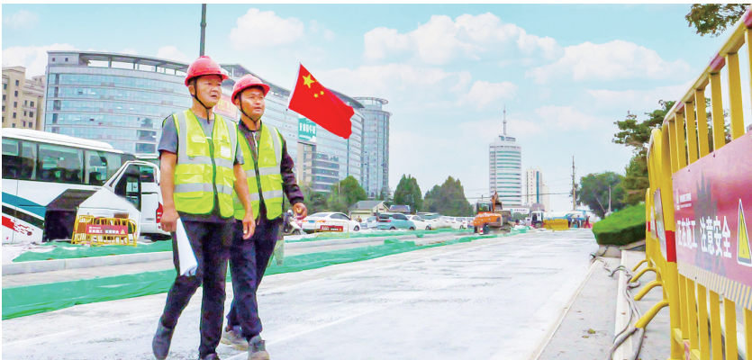
在莱芜鲁中大街提升改造项目现场,工程管理人员正在检查沥青摊铺质量。
